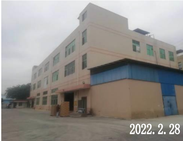
项目 A 栋厂房
