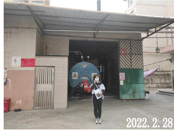
工程师现场勘察图片②
