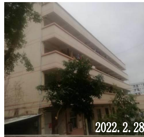
项目东北面工业区宿舍
