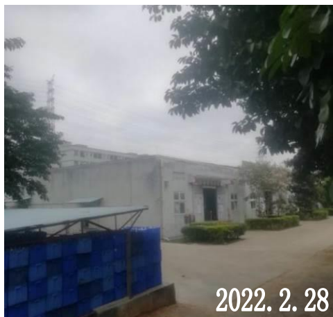
项目北面工业厂房
