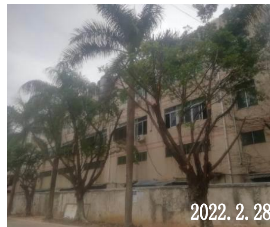
项目东面工业厂房
