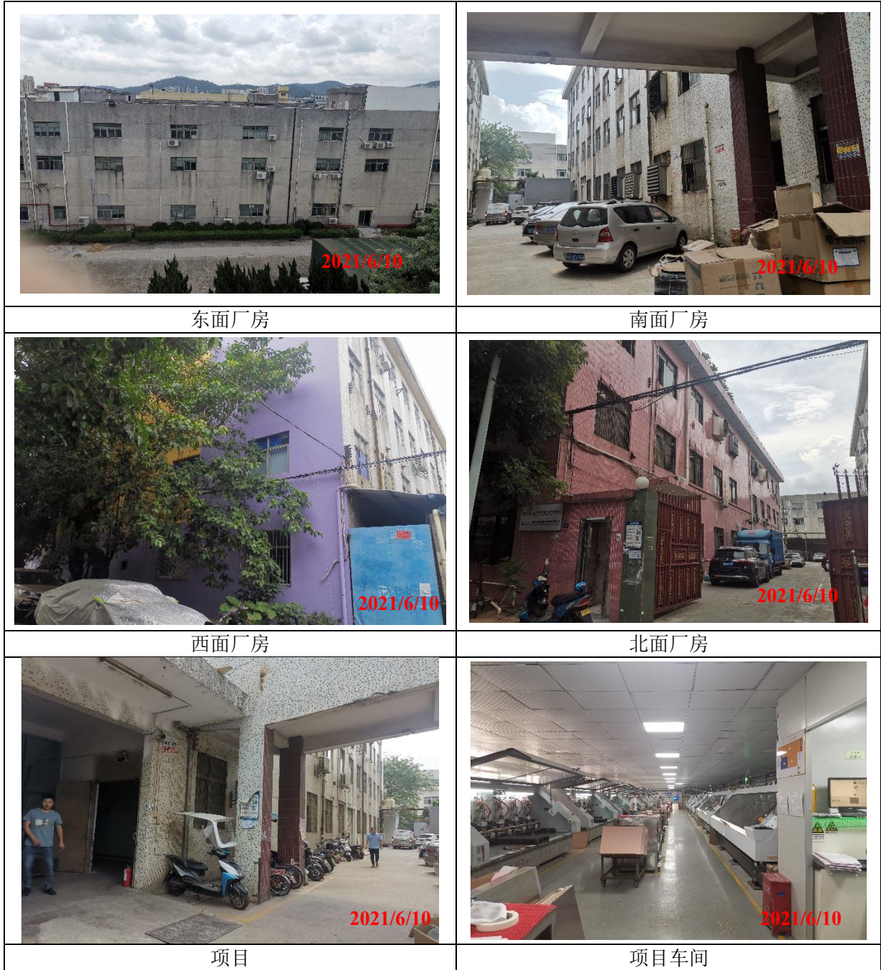
附图 4 项目位置厂房外观和车间内现状
